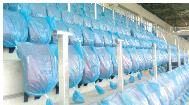
Stadion Trnava - přichycení sedaček do kolejnic TA 38/17 - 6m pomocí T šroubů 38/17.
