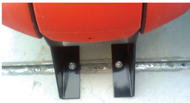
Stadion Trnava - přichycení sedaček do kolejnic TA 38/17 - 6m pomocí T šroubů 38/17.
